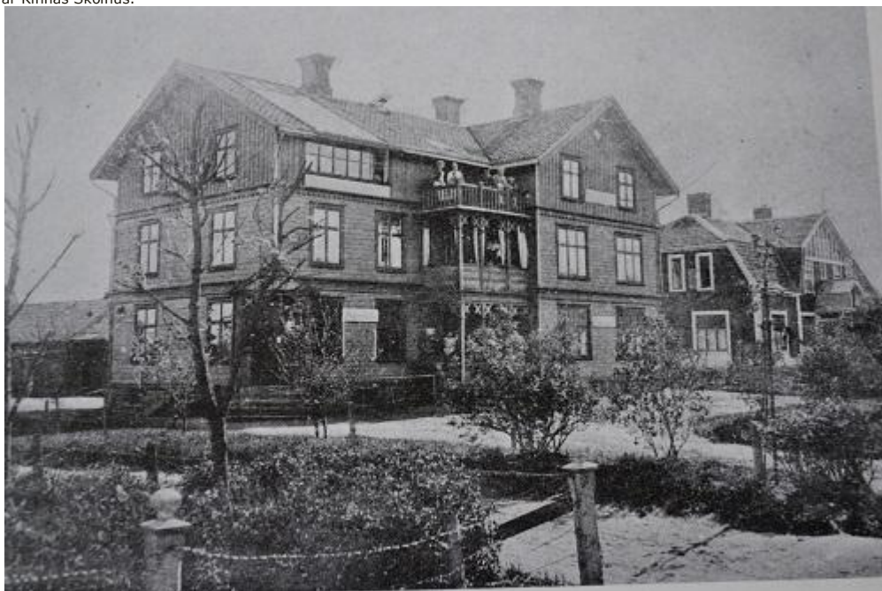
Detta hus byggdes av Gottfrid Nilsson 1898. Han kom till Kinna 1892 som fotograf och hyrde hos Carl Sprakarn på Snickaregården innan han öppnade ateljé här i huset. Kinns första apotek startade här 1900 med apotekare Bergqvist som chef. Här öppnades också bankkontor. Ett stort tack till alla som skickat bilder till Halvdan Arvidsson när han gav ut Kinnabilder. Därifrån har vi hämtat flera av de äldre bilderna. Vi som sammanställt uppgifterna är med i studiecirkeln Kinna by under 150 år som leds av Kjell-Åke Bergqvist.
