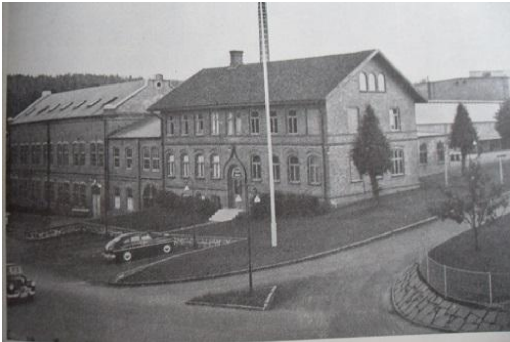
Häggådalens Mekaniska Linneväfveri startades av Rudolf Andrén och Axel Åberg 1894. Rudolf kom från Långhem 1881 och var bokhållare hos Håkan Andersson på Stomslyckan. Han övertog dennes förläggarverksamhet när han dog och anställde Axel Åberg från Öxnevalle som bokhållare.
